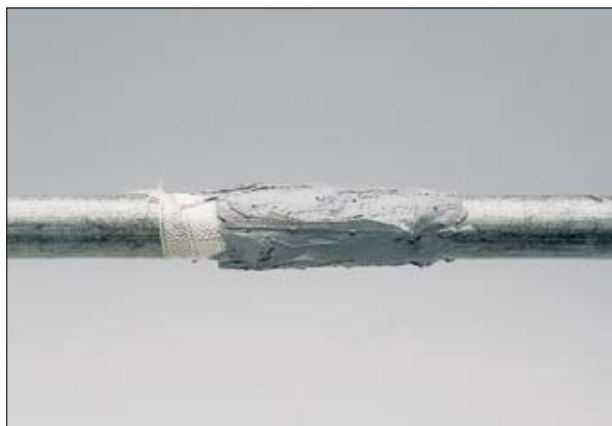
Slika 4 nužna popravka čelične cevi
