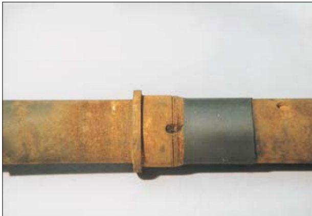
Slika 2 Popravka pogonskog vratila
